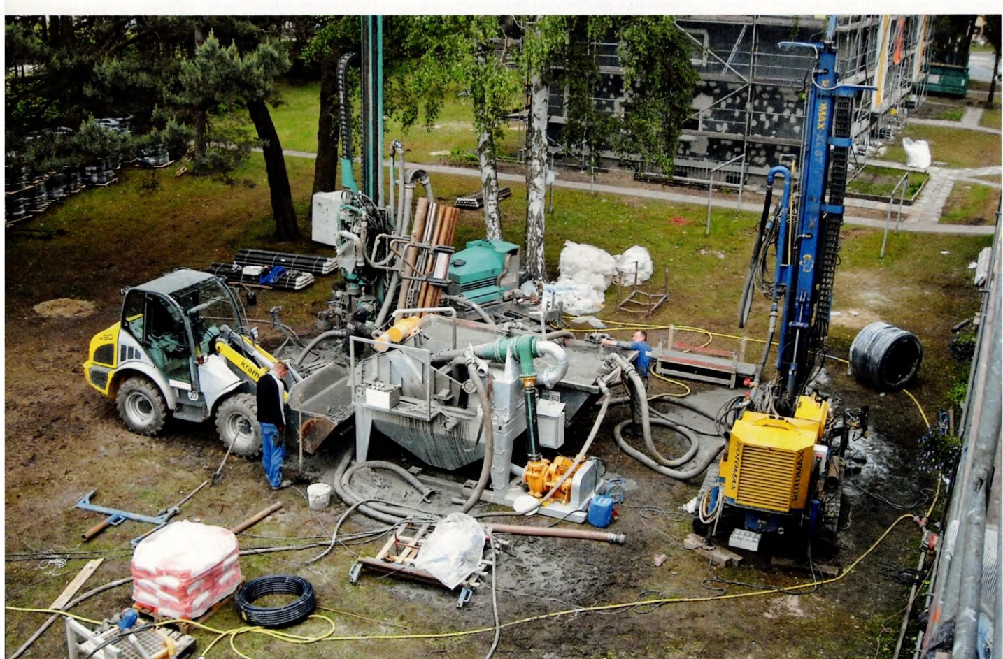
Abb. 1 – Zwei Bohrmannschaften beim Abteufen von Erdwärmesonden auf dem Cluster Celle
